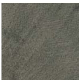
RESINA E CEMENTO
