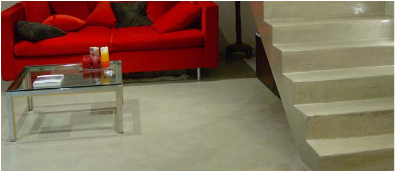
PAVIMENTO E RIVESTIMENTO SCALE IN RESINA QUARZO COLORATO E RESINA CEMENTO NATURALE.
