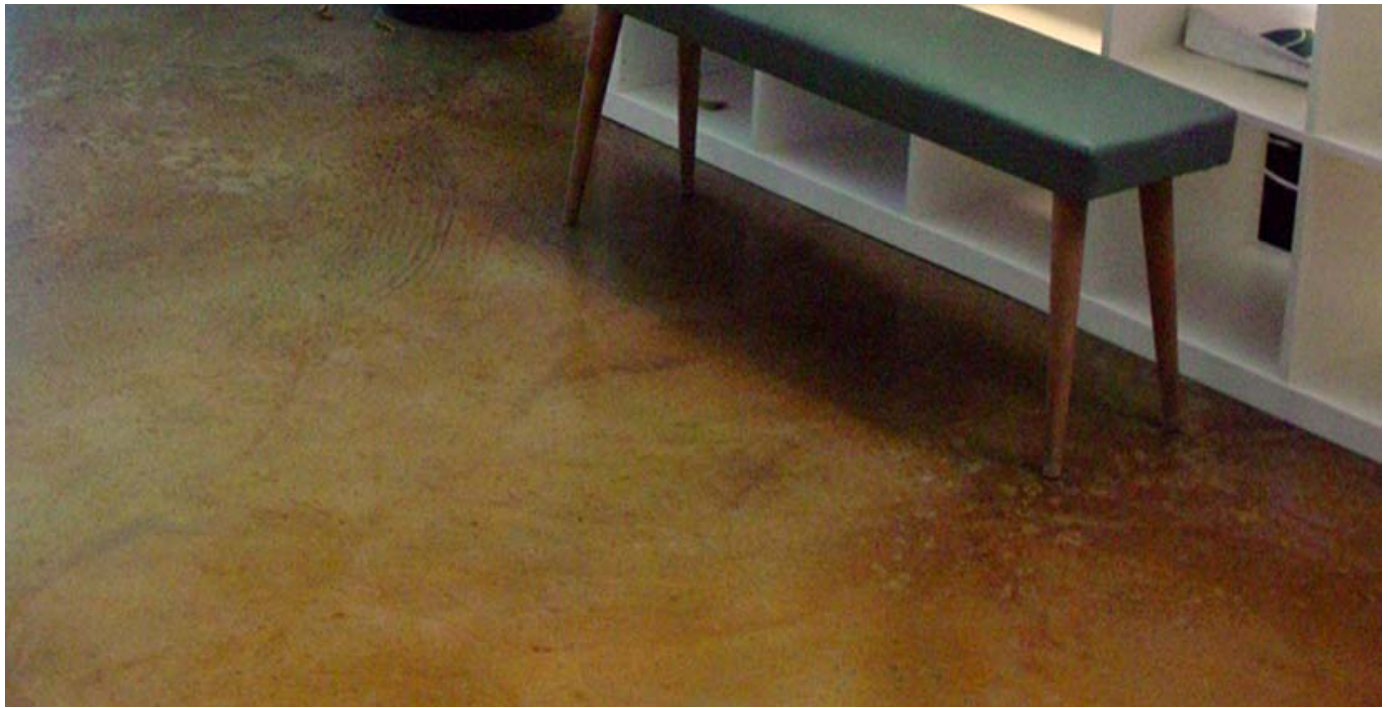
PAVIMENTO E RIVESTIMENTO SCALE IN RESINA QUARZO COLORATO E RESINA CEMENTO NATURALE.
