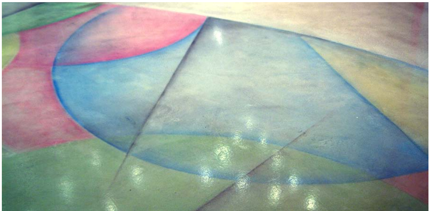
RIVESTIMENTO MULTISTRATO QUARZO COLORATO E PAVIMENTO MULTISTRATO QUARZO DISEGNATO.
