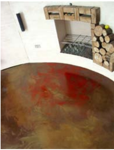
PAVIMENTO IN RESINA AUTOLIVELLANTE CON OSSIDI E ORO,.
